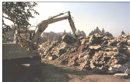
Einbau der Steine auf Schotterkern
