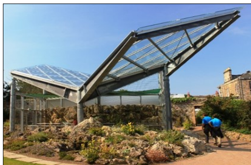
Kühne Glaskonstruktion Tuffsteinhaus
